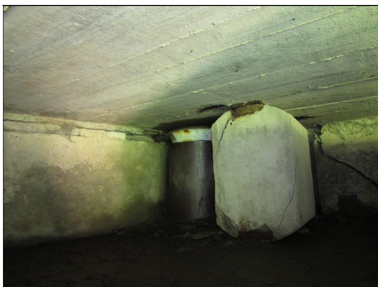
Kyvné ložisko na opěře 5 - s trhlinami, které je nutno sledovat. V pozadí svislý svod odvodnění, který nefunguje a voda zaplavuje úložný práh a stéká po opěře.
