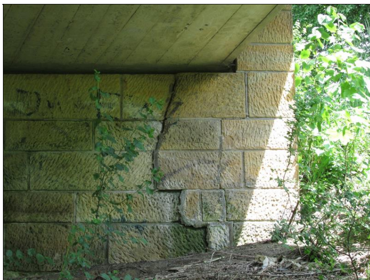
Detail trhliny na opěře 1
