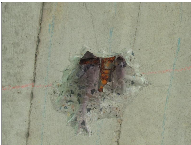
nezapravená sonda po diagnostice - výztuž koroduje
