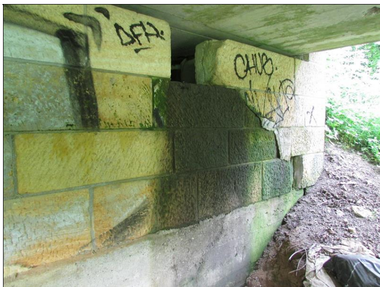
Pohled na opěru 5 - zatékání z odvodňovače přes úložný práh
