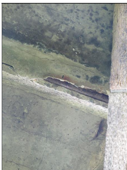
Obnažená korodující výztuž na hraně NK u P2 vpravo
