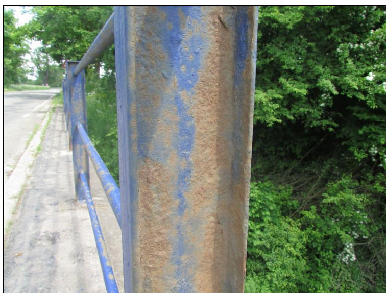
Koroze zábradlí
