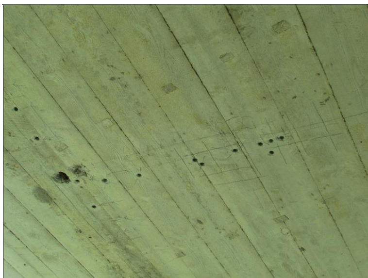
Obnažená korodující výztuž na hraně NK u P2 vpravo
