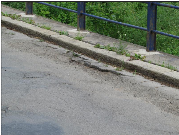
Výtluky, vyjeté koleje ve vozovce
