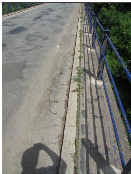
Vyjeté koleje ve vozovce
